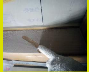
施工後の状態
