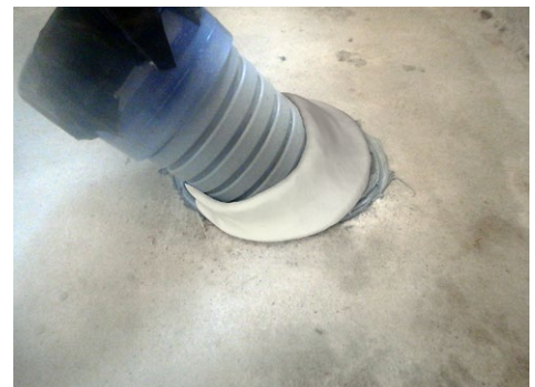
※さや管と排水管の隙間へ充填。
