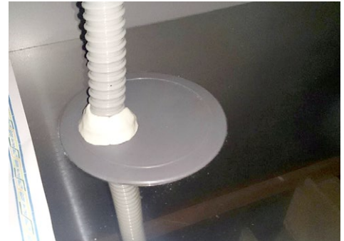
※キッチン排水管の隙間へ充填。
